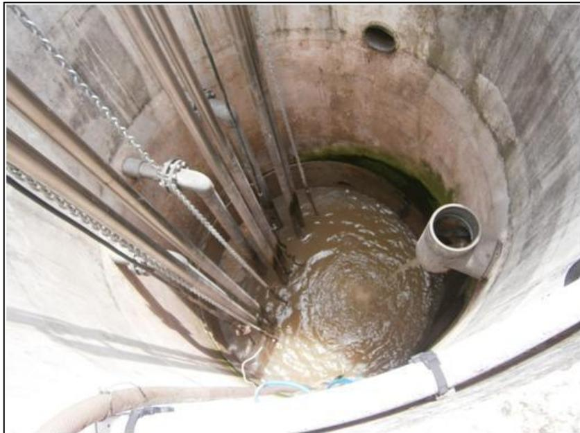
Le poste de relevage est équipé de 3 pompes de 22,7 m<sup>3</sup>/h, d'une sonde de niveau permettant de réguler le fonctionnement des pompes et de déclencher les seuils d'alerte. Le poste est enfin équipé d'une crépine de prélèvement des effluents pour les analyses.
