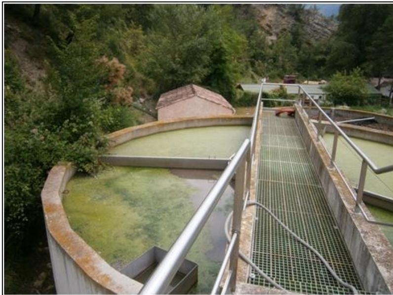
Elles sont ensuite dirigées dans le filtre bactérien avant d'être clarifiées dans le décanteur lamellaire.
