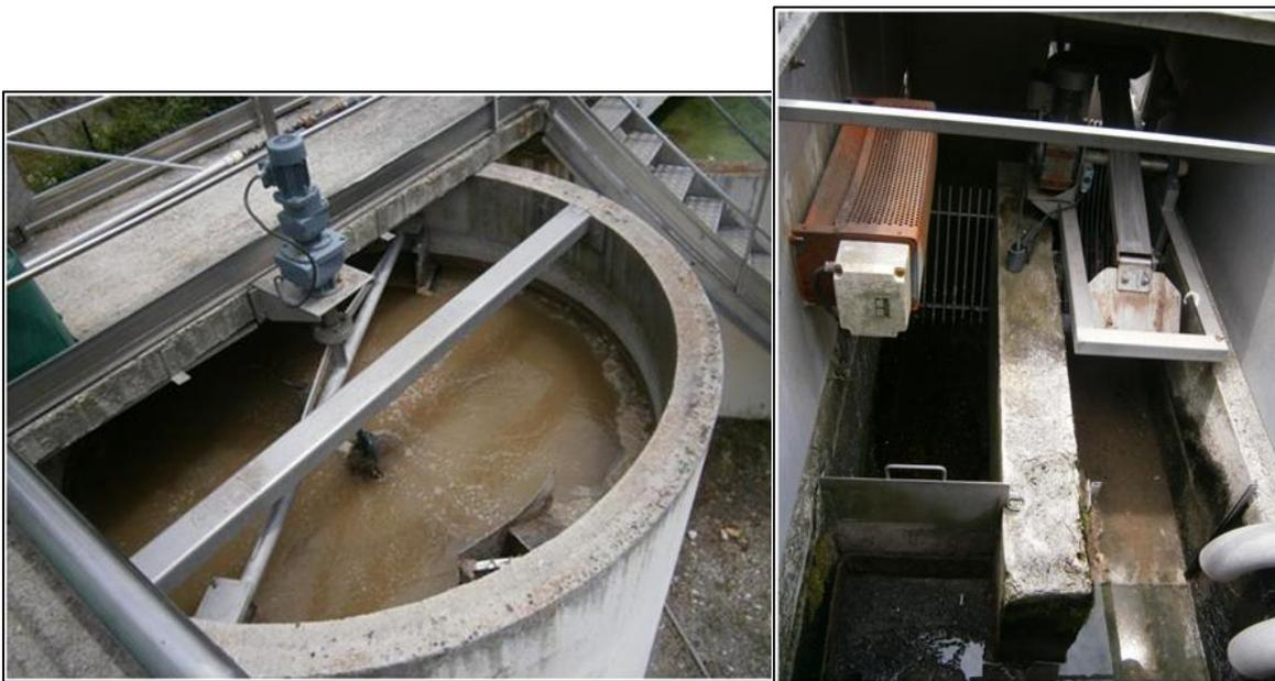
Dans un second temps, les effluents s'écoulent gravitairement dans le prétraitement. Les graisses récupérées en surfaces et les sables en fond de cuve sont alors dirigés par des racleurs dans les fosses à graisses et à sables.
